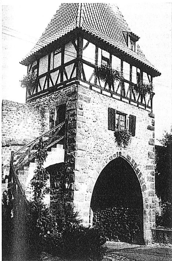
Fig. 8 - Châtenois : tour-porte du cimetière fortifié, avec escalier extérieur conduisant à l'étage et au chemin de ronde.
