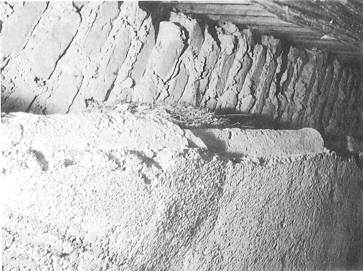
Fig. 7. Détail de la façade occidentale du sanctuaire primitif, côté Sud, présentant le crépi bien conservé, les traces de tuiles canal et l'exhaussement en briques rouges recevant la charpente de la nef de 1441.
