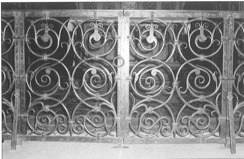
Fig. 12 : Détail des deux vantaux du banc de communion réalisé en fer forgé en 1875 (Photo. F. Baumann).
